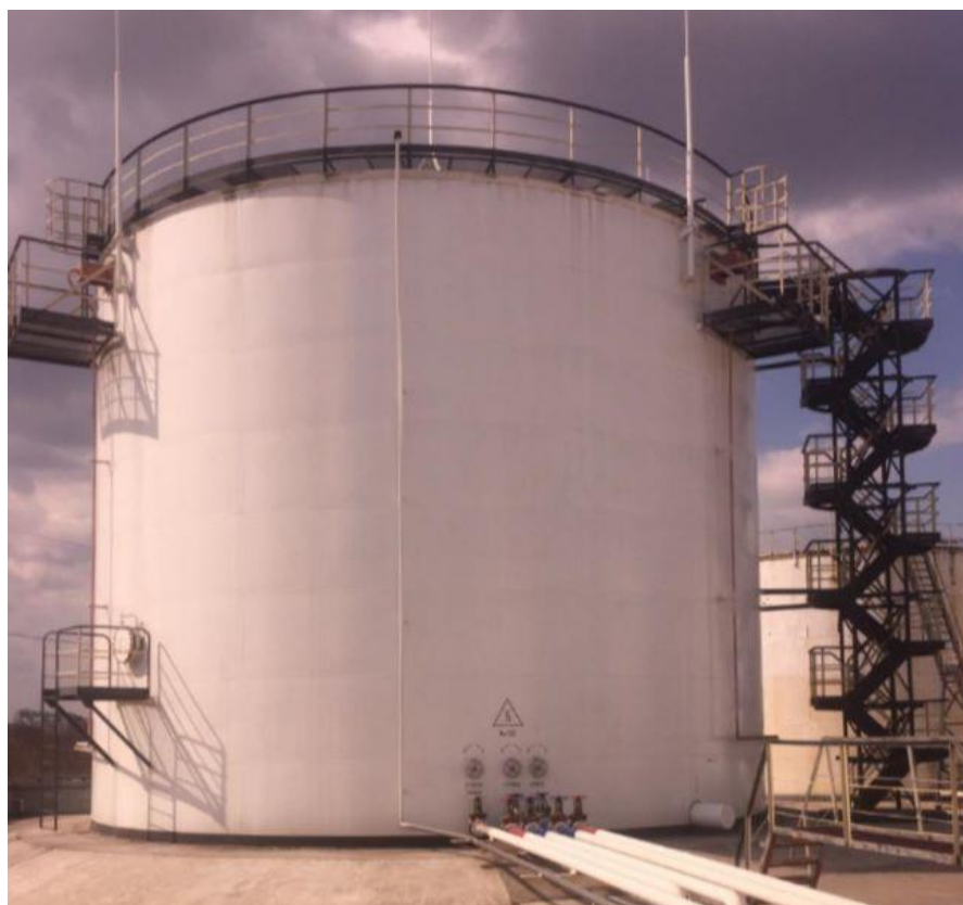
Рисунок 1 – Общий вид резервуара стального вертикального цилиндрического РВСП-2000
