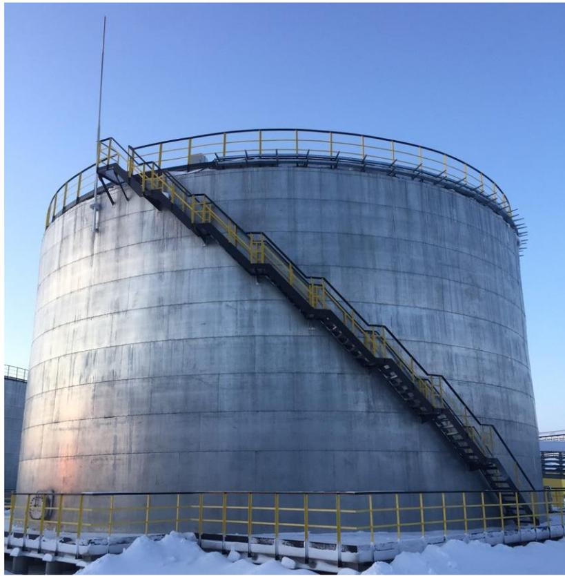
Рисунок 3 – Общий вид резервуара стального вертикального цилиндрического РВС-5000
