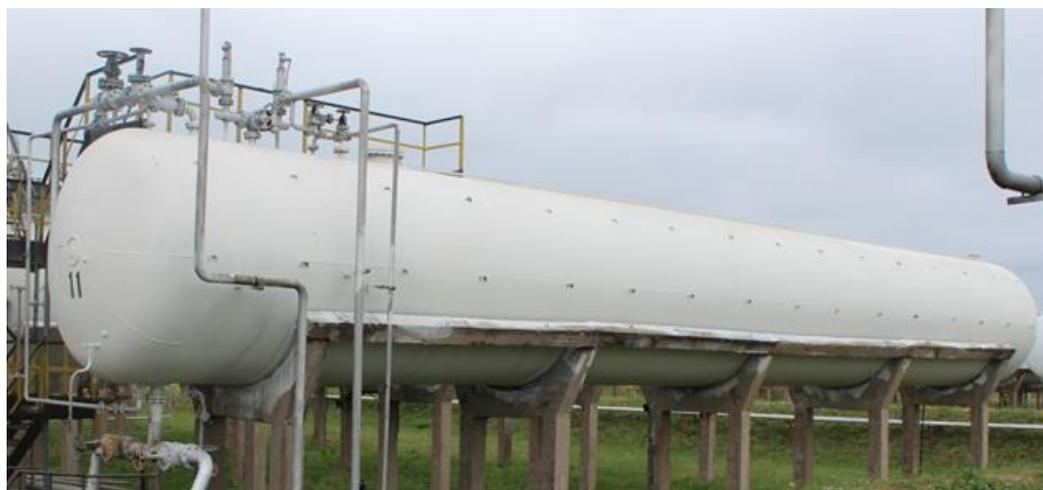
Рисунок 1 – Общий вид резервуаров стальных горизонтальных цилиндрических РГС-175
