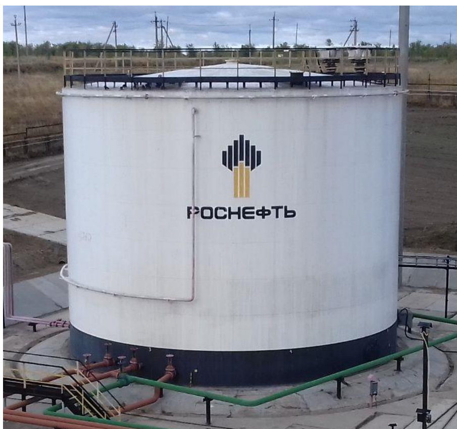
Рисунок 1 – Общий вид резервуара стального вертикального цилиндрического РВС-2000
