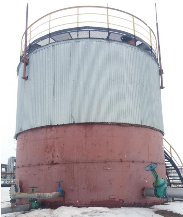
Рисунок 1 – Общий вид резервуаров стальных вертикальных цилиндрических РВС-400
