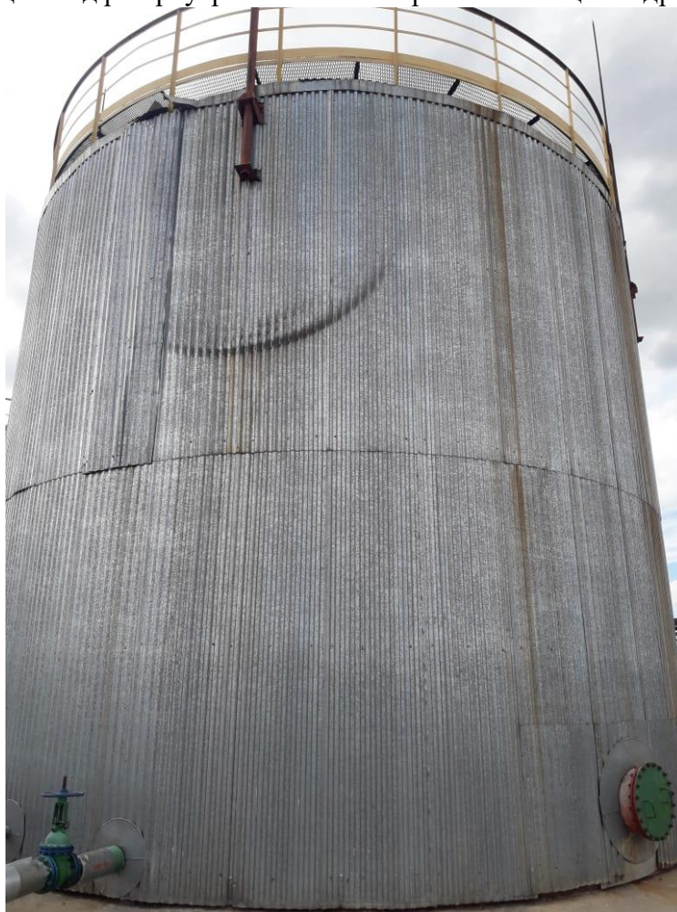
Рисунок 2 – Общий вид резервуара стального вертикального цилиндрического РВС-700
