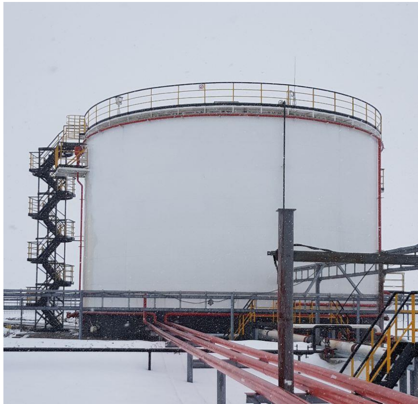
Рисунок 1 – Общий вид резервуаров стальных вертикальных цилиндрических РВС-3000
