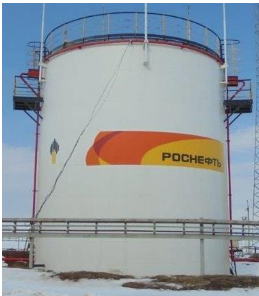
Рисунок 1 – Общий вид резервуаров стальных вертикальных цилиндрических РВС-1000
