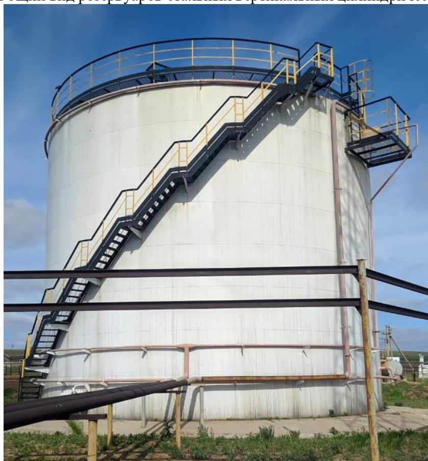
Рисунок 2 – Общий вид резервуаров стальных вертикальных цилиндрических РВС-2000
