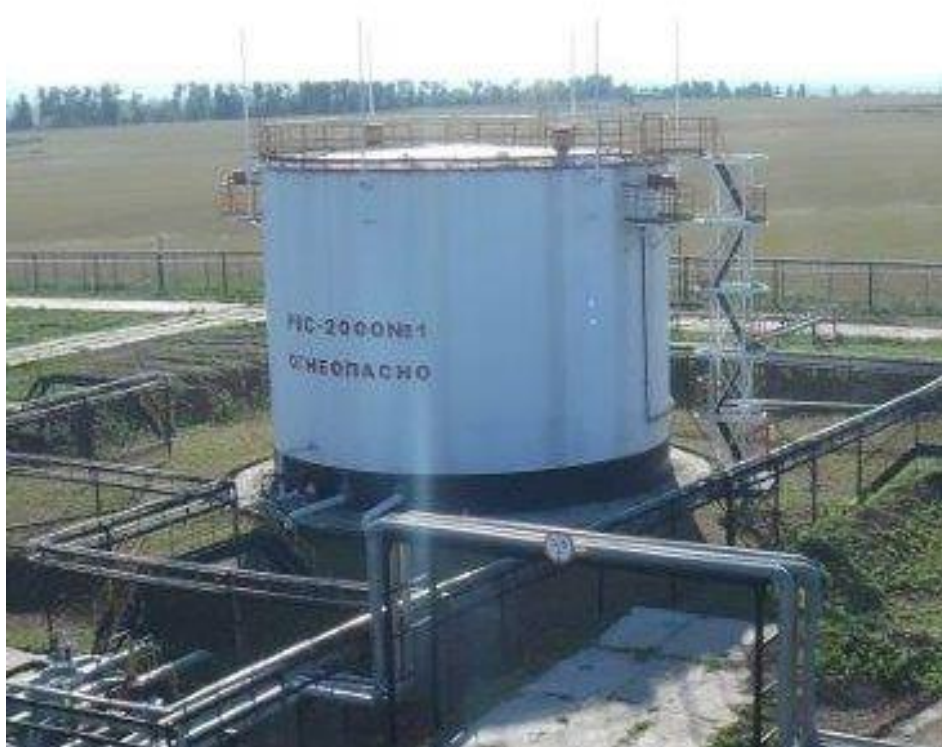
Рисунок 1 – Общий вид резервуара стального вертикального цилиндрического РВС-2000
