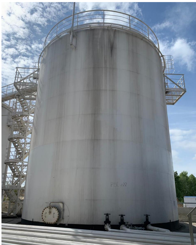
Рисунок 1 – Общий вид резервуаров РВС-1000
