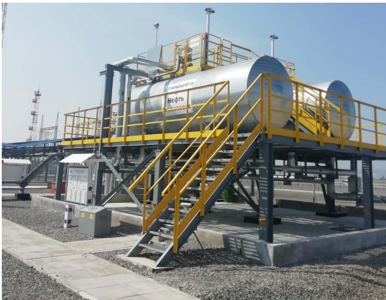
Рисунок 1 – Общий вид резервуаров РГС-20
