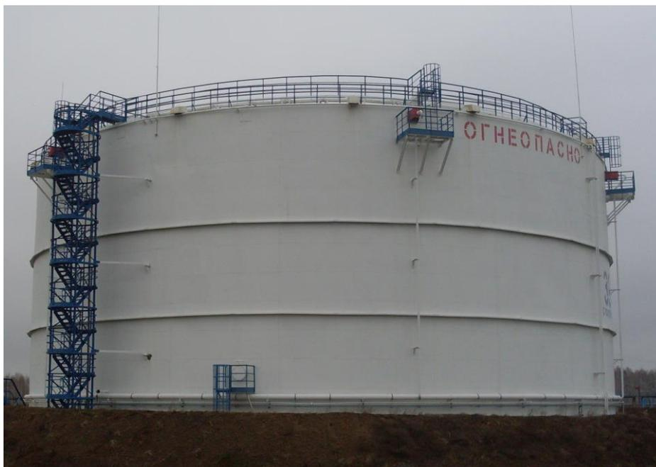
Рисунок 1 – Общий вид резервуаров стальных вертикальных цилиндрических с понтоном РВСП-20000
