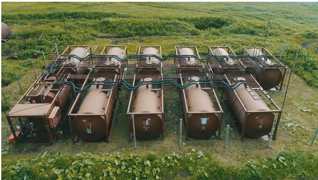
Рисунок 1 – Общий вид резервуаров Рк-24
