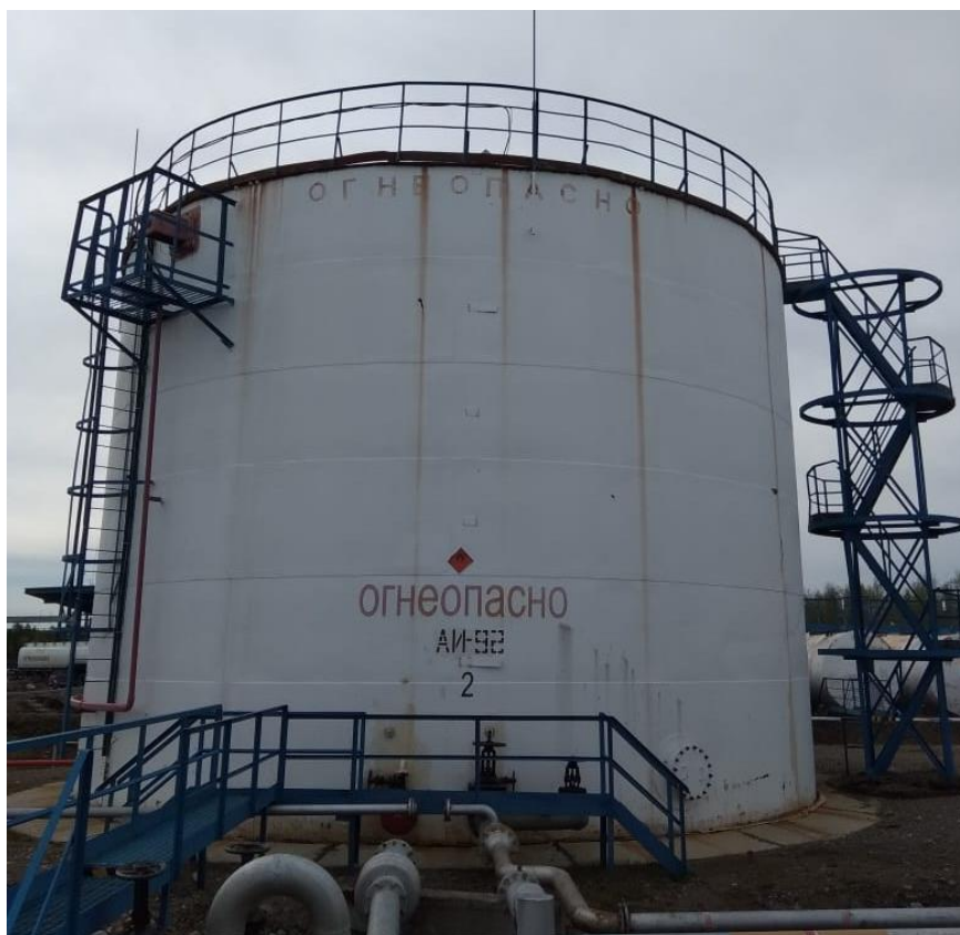
Рисунок 1 – Общий вид резервуаров РВС-1000
