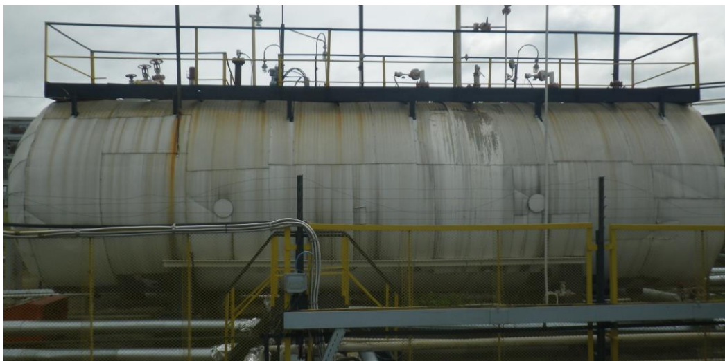
Рисунок 2 – Общий вид резервуара стального горизонтального цилиндрического РГС-80
