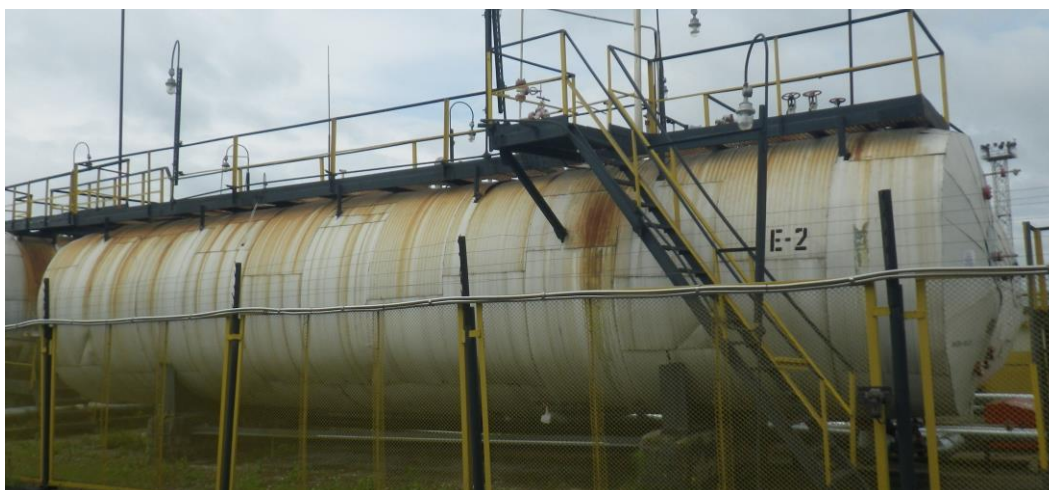
Рисунок 3 – Общий вид резервуара стального горизонтального цилиндрического РГС-100
