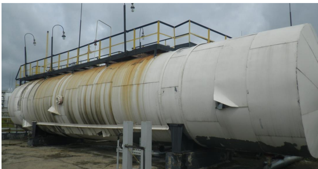
Рисунок 4 – Общий вид резервуара стального горизонтального цилиндрического РГС-160
