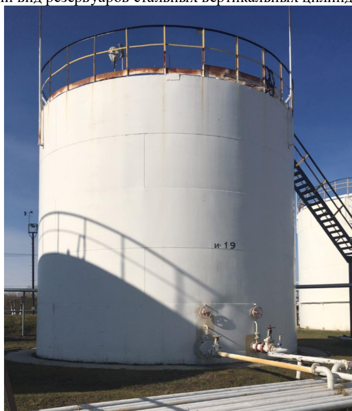
Рисунок 2 – Общий вид резервуаров стальных вертикальных цилиндрических РВС-400
