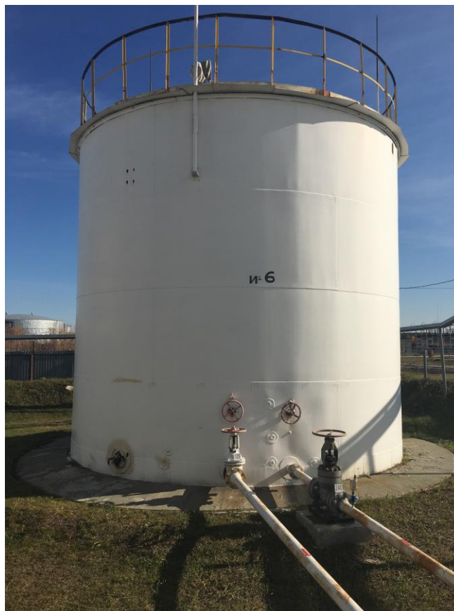
Рисунок 1 – Общий вид резервуаров стальных вертикальных цилиндрических РВС-200
