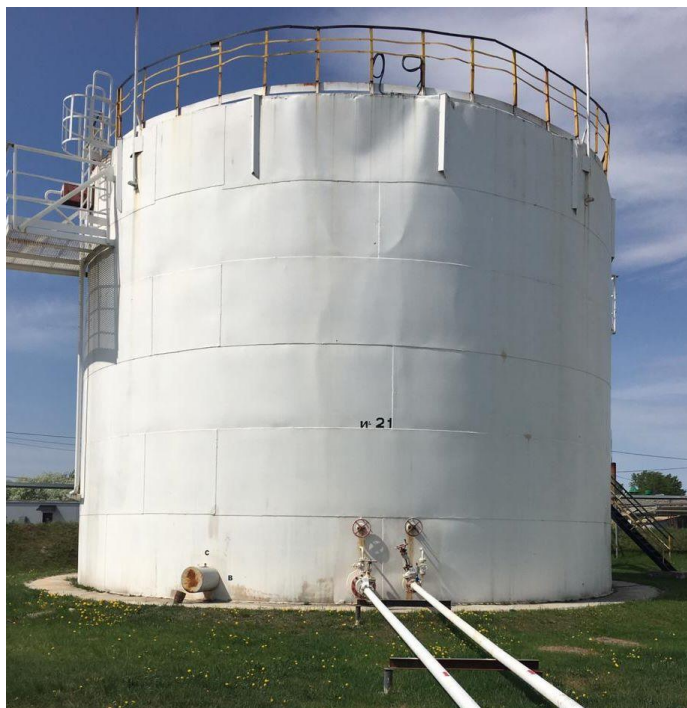
Рисунок 3 – Общий вид резервуаров стальных вертикальных цилиндрических РВСП-1000
