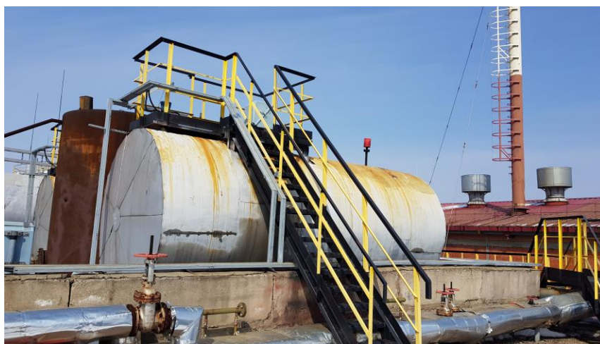
Рисунок 1 – Общий вид резервуаров стальных горизонтальных цилиндрических РГС-35
