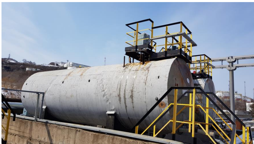
Рисунок 2 – Общий вид резервуаров стальных горизонтальных цилиндрических РГС-50
