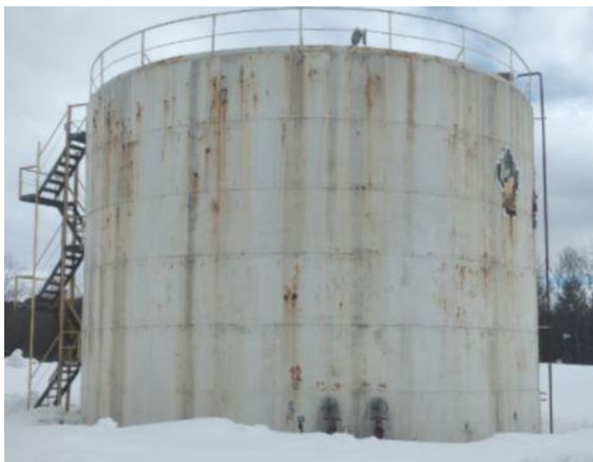
Рисунок 2 – Общий вид резервуаров стальных вертикальных цилиндрических РВС-1000
