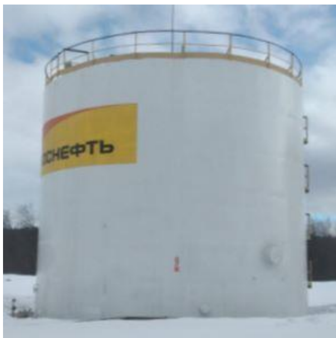
Рисунок 1 – Общий вид резервуаров стальных вертикальных цилиндрических РВС-700
