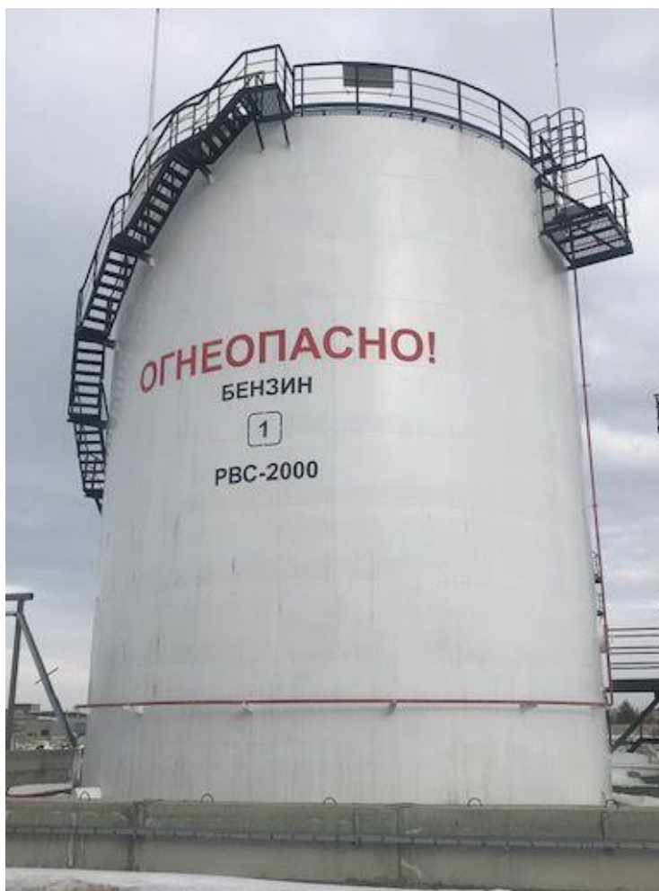
Рисунок 2 – Общий вид резервуаров стальных вертикальных цилиндрических РВС-2000
