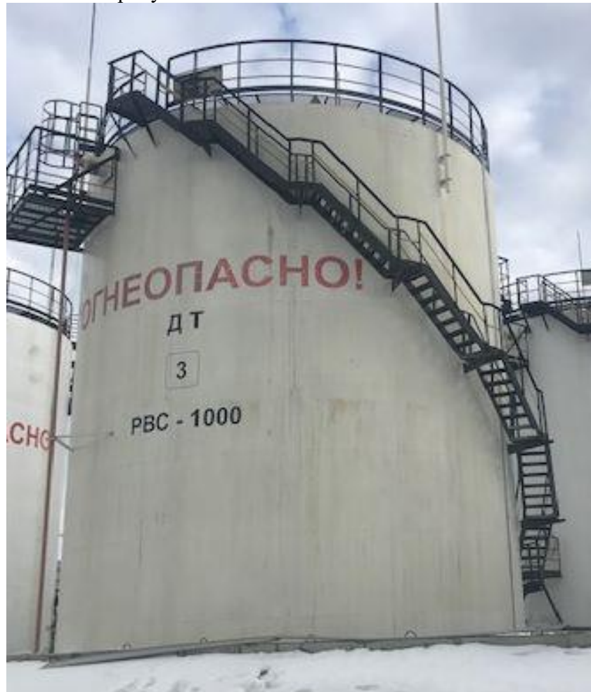
Рисунок 1 – Общий вид резервуаров стальных вертикальных цилиндрических РВС-1000
