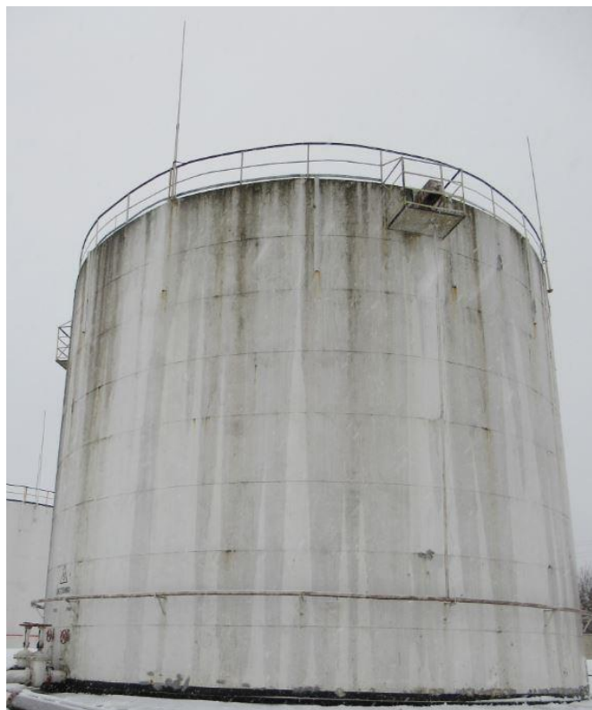
Рисунок 3 – Общий вид резервуаров стальных вертикальных цилиндрических РВС-2000
