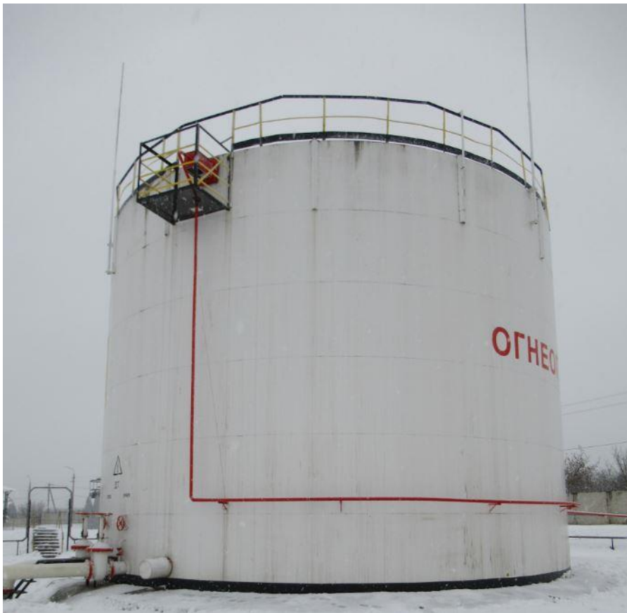
Рисунок 1 – Общий вид резервуаров стальных вертикальных цилиндрических РВС-1000
