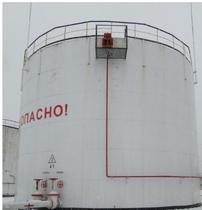
Рисунок 2 – Общий вид резервуаров стальных вертикальных цилиндрических РВСП-1000
