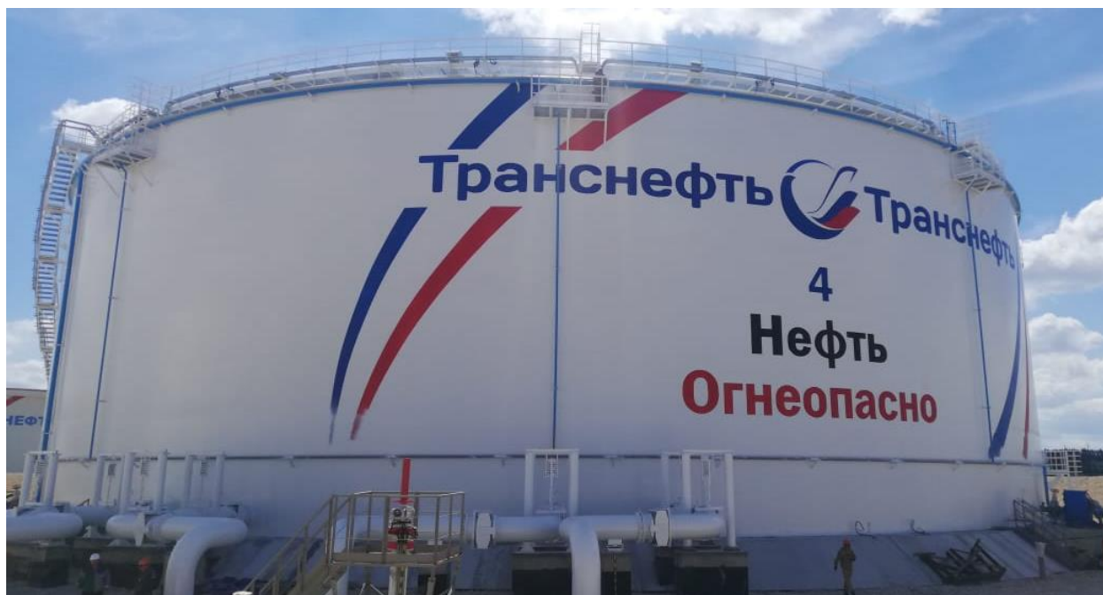
Рисунок 1 – Общий вид резервуара стального вертикального цилиндрического РВСП-50000
