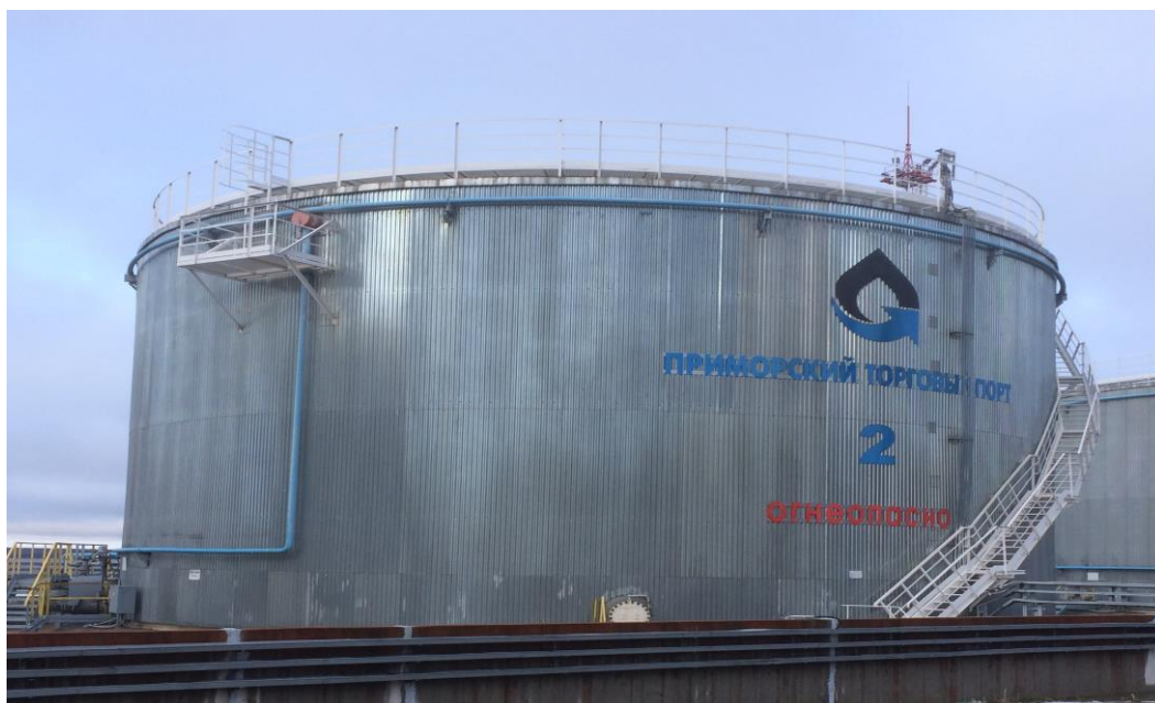
Рисунок 1 – Общий вид резервуара стального вертикального цилиндрического теплоизолированного РВС-5000
