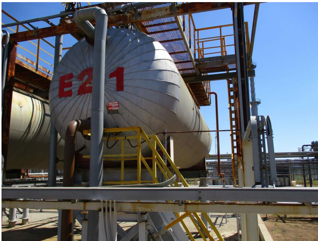
Рисунок 1 – Общий вид резервуаров РГС-60
