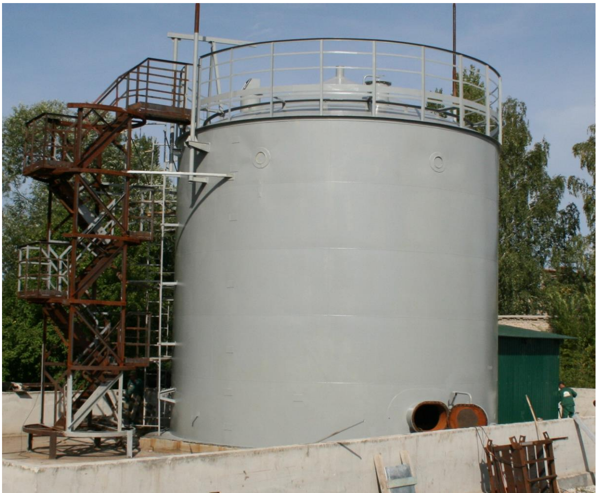
Рисунок 1 – Резервуар вертикальный стальной РВС-400 №2К
