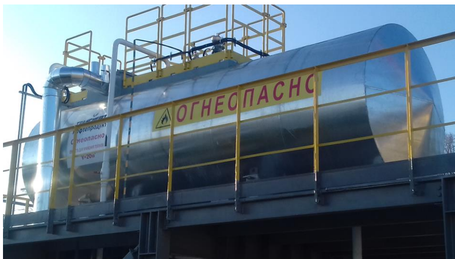
Рисунок 1 – Общий вид резервуара стального горизонтального цилиндрического РГС-20
