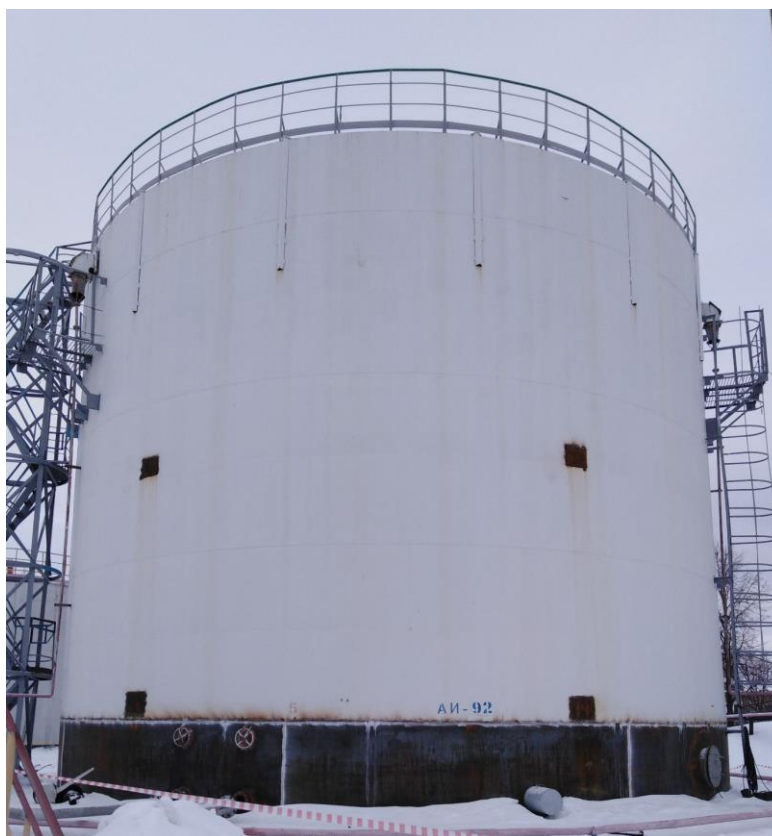
Рисунок 9 – Общий вид резервуаров стальных вертикальных цилиндрических РВС-2000
