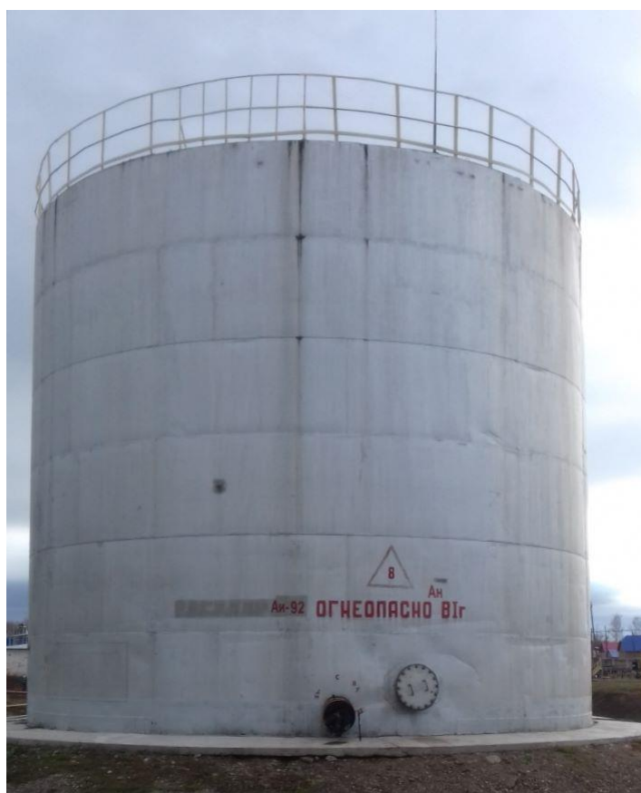
Рисунок 6 – Общий вид резервуаров стальных вертикальных цилиндрических РВС-700
