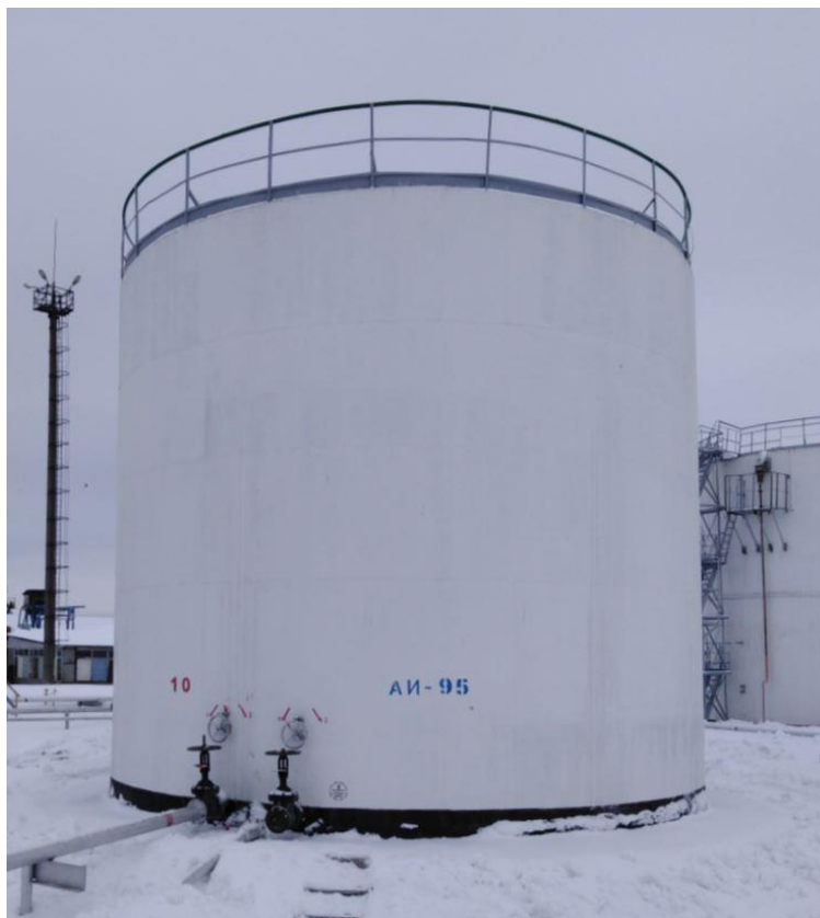
Рисунок 5 – Общий вид резервуара стального вертикального цилиндрического РВСП-400
