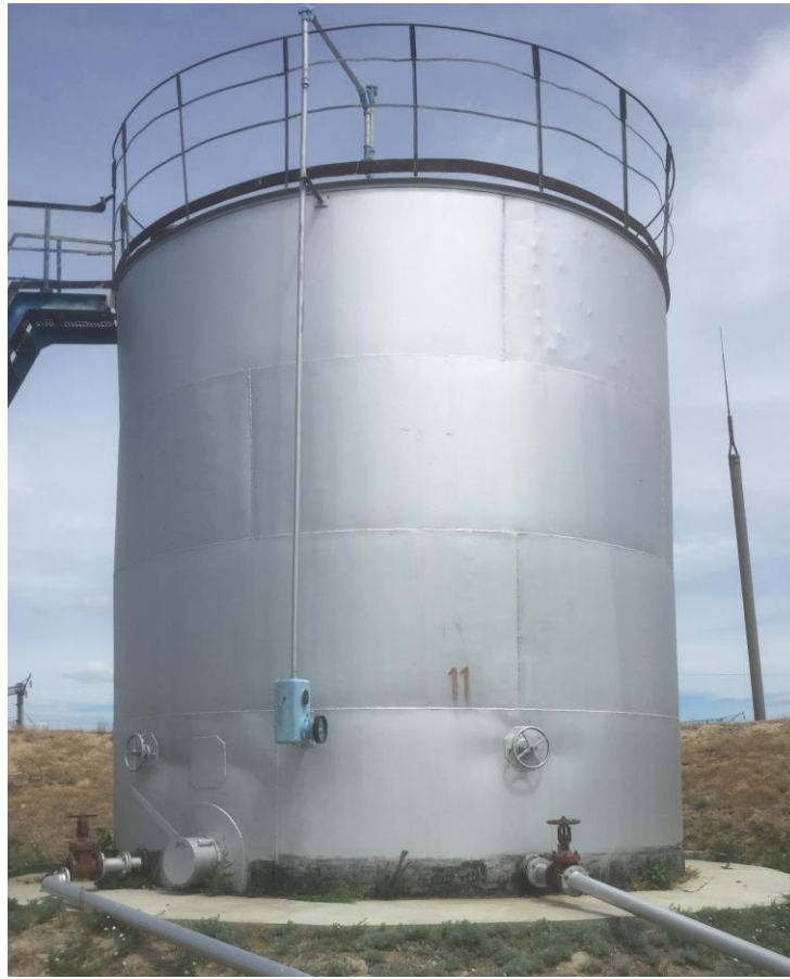
Рисунок 1 – Общий вид резервуаров стальных вертикальных цилиндрических РВС-100
