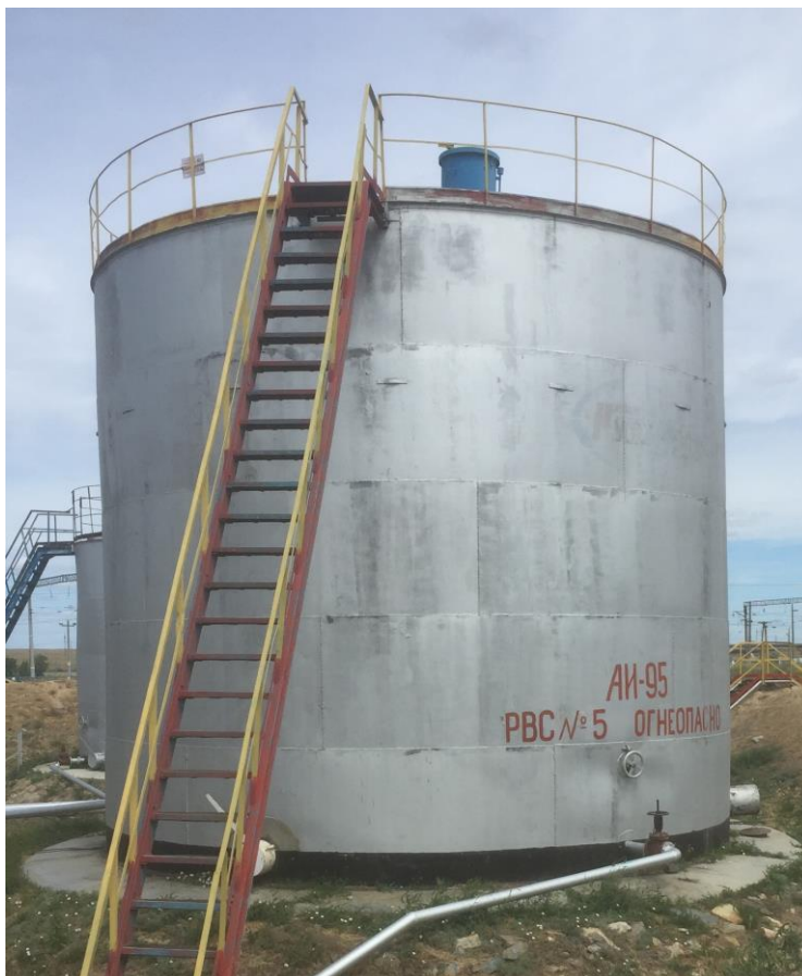
Рисунок 3 – Общий вид резервуара стального вертикального цилиндрического РВС-300
