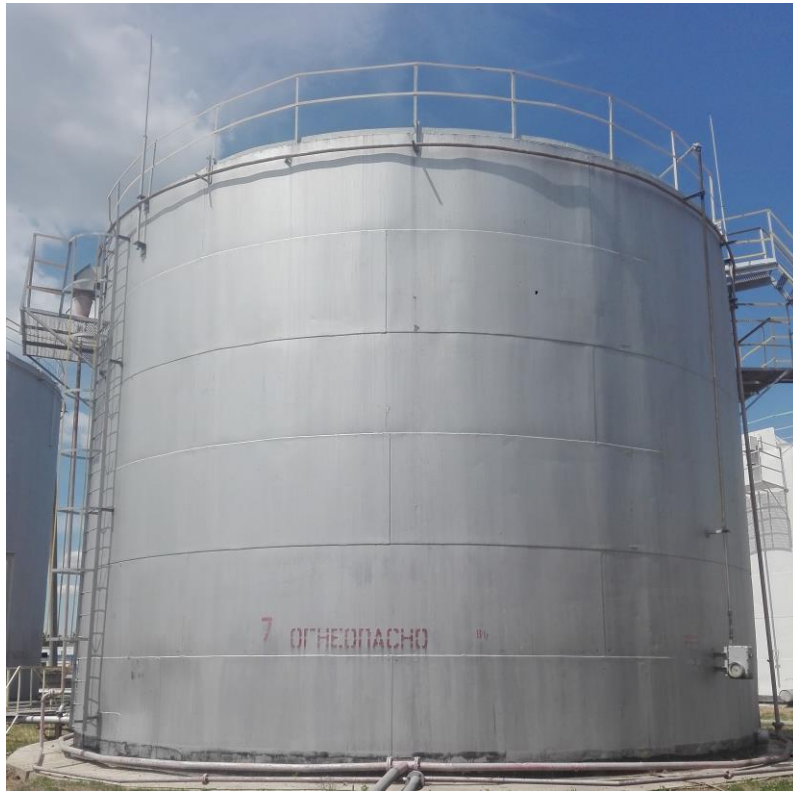
Рисунок 7 – Общий вид резервуаров стальных вертикальных цилиндрических РВС-1000
