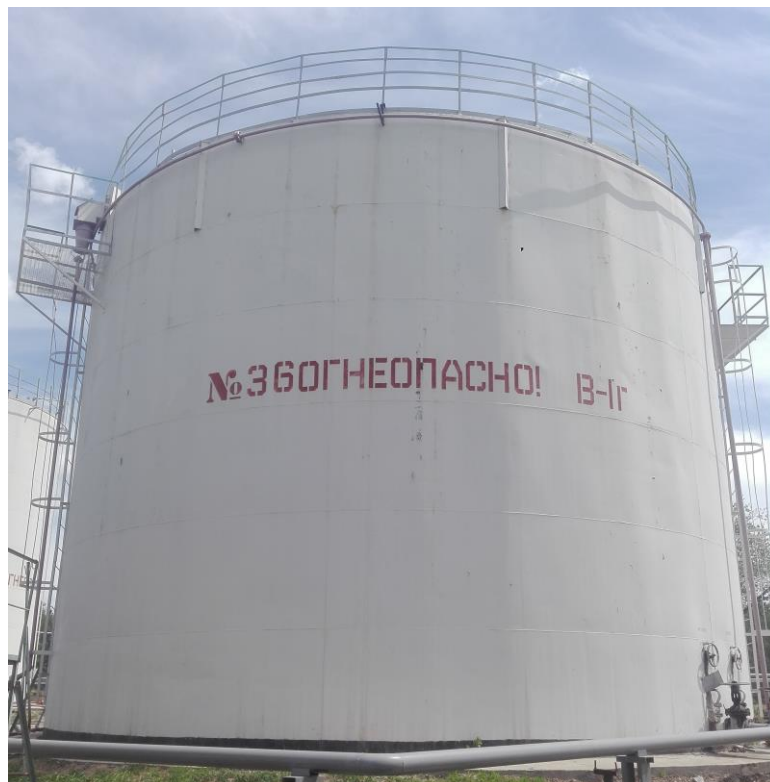
Рисунок 8 – Общий вид резервуара стального вертикального цилиндрического РВСП-1000
