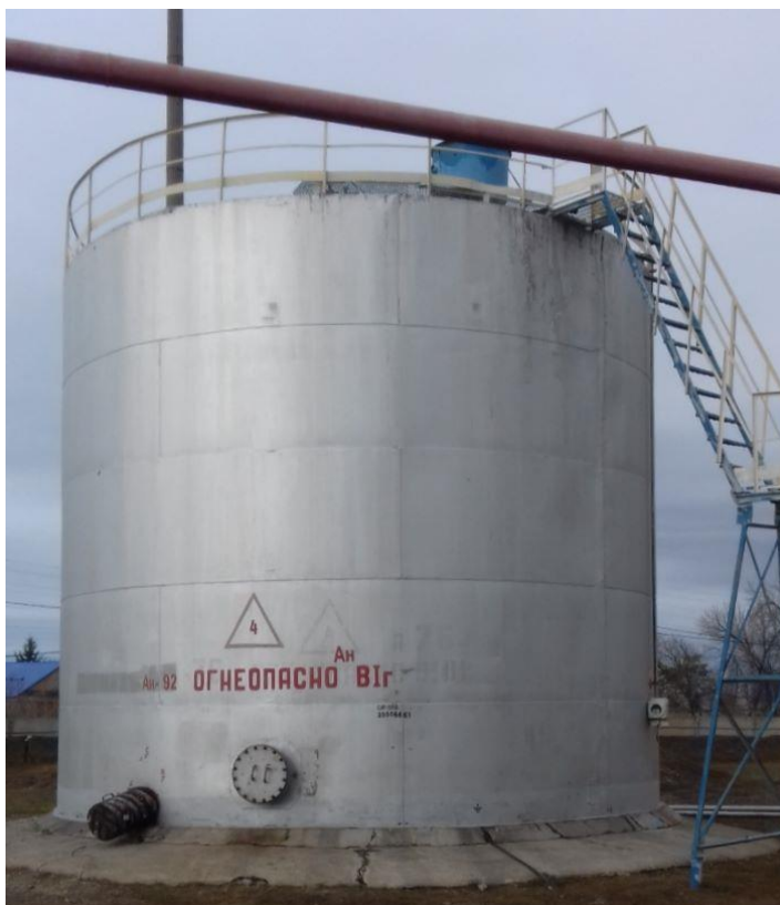
Рисунок 4 – Общий вид резервуаров стальных вертикальных цилиндрических РВС-400
