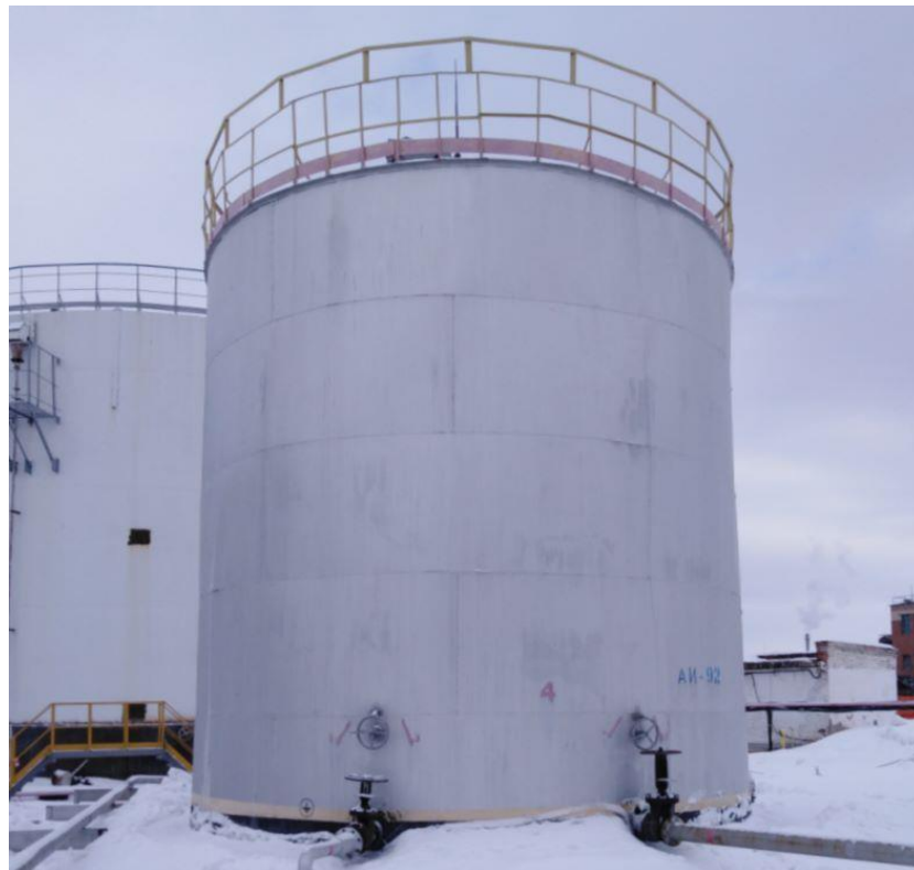
Рисунок 2 – Общий вид резервуара стального вертикального цилиндрического РВС-200
