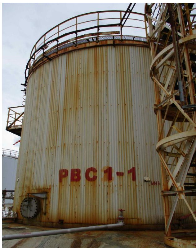
Рисунок 1 – Общий вид резервуара РВСП-600
