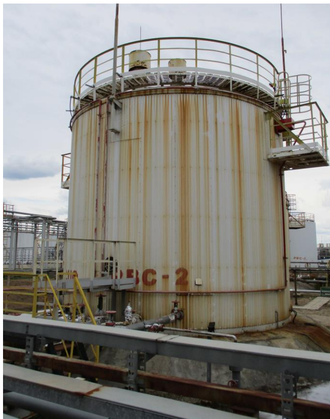
Рисунок 1 – Общий вид резервуара ВСП-400
