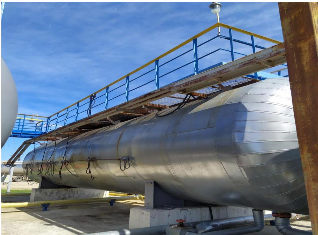
Рисунок 1 – Общий вид резервуара стального горизонтального цилиндрического РГС-100
