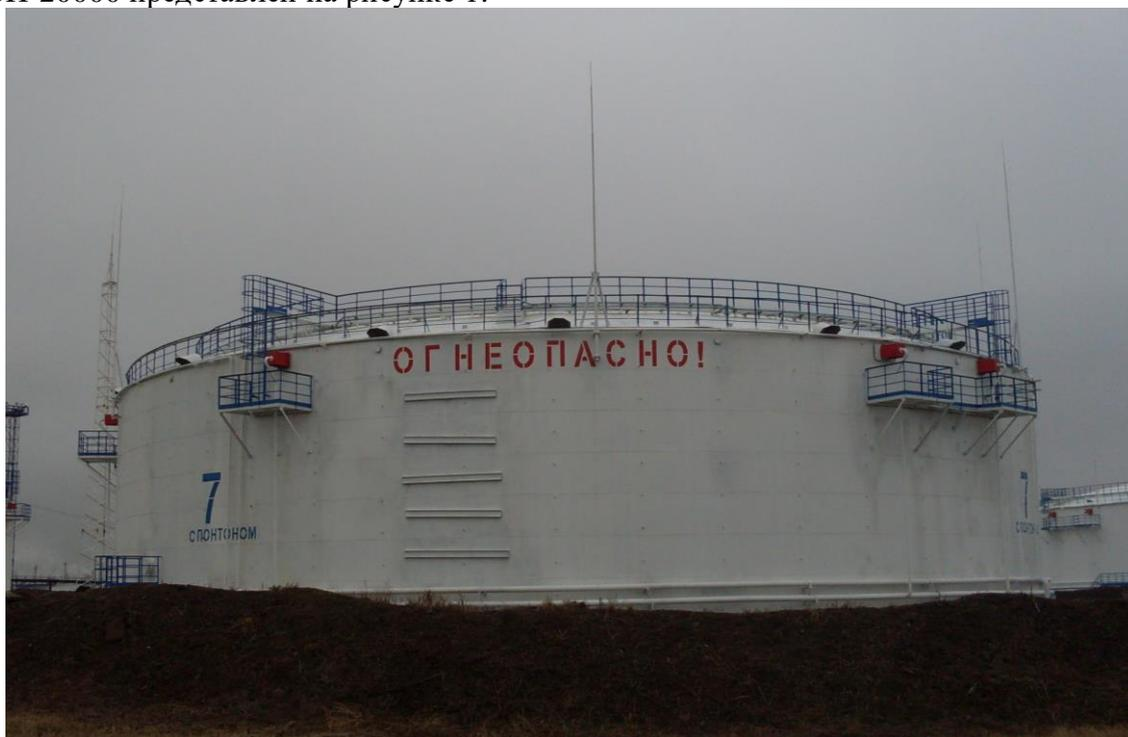
Рисунок 1 – Общий вид резервуаров стальных вертикальных цилиндрических с понтоном РВСП-20000
