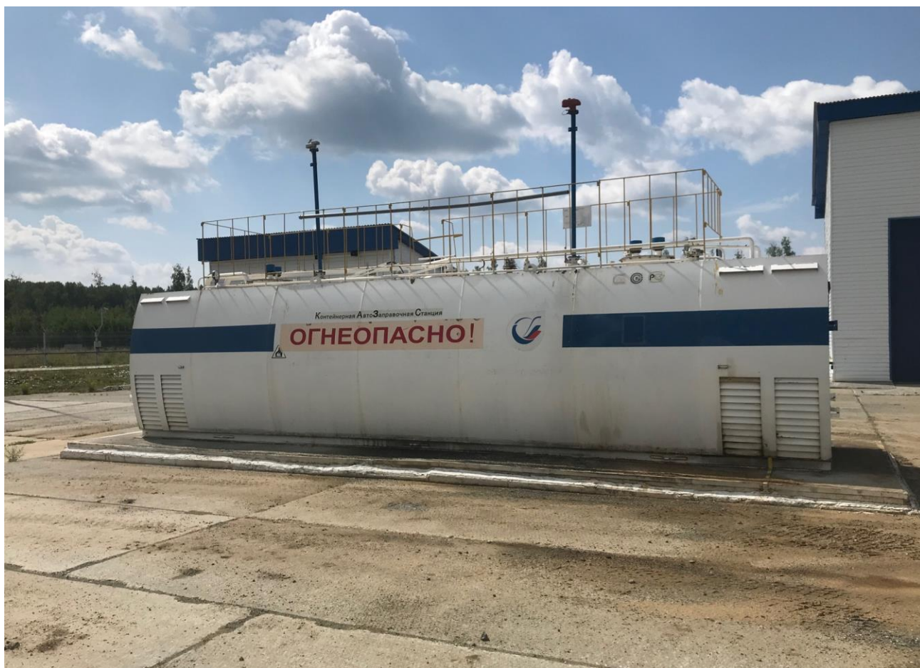
Рисунок 1 – Общий вид резервуаров РГС-25
