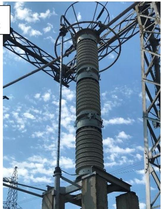
Рисунок 1 – Общий вид трансформаторов напряжения антирезонансных однофазных НАМИ, модификация НАМИ-110 УХЛ1
