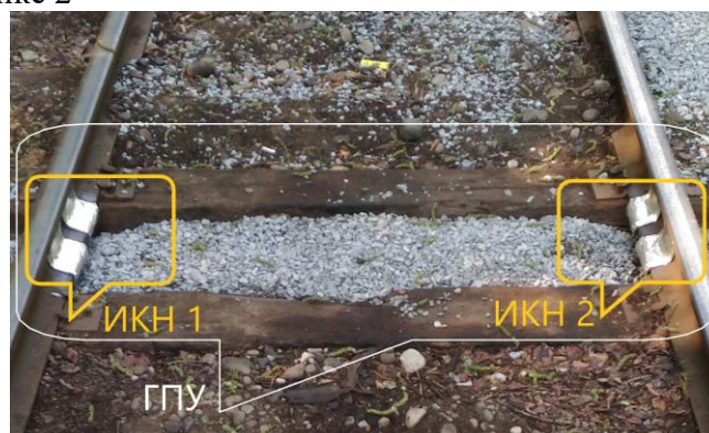
Рисунок 1 - Общий вид весов ВРТ-04
