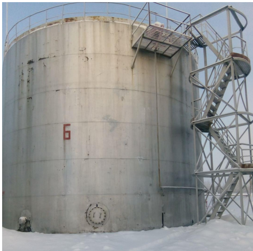
Рисунок 1 – Общий вид резервуара стального вертикального цилиндрического РВС-1000
