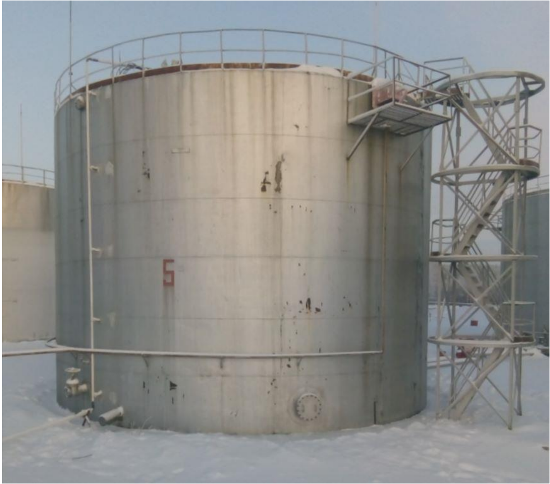
Рисунок 2 – Общий вид резервуара стального вертикального цилиндрического РВС-1000
