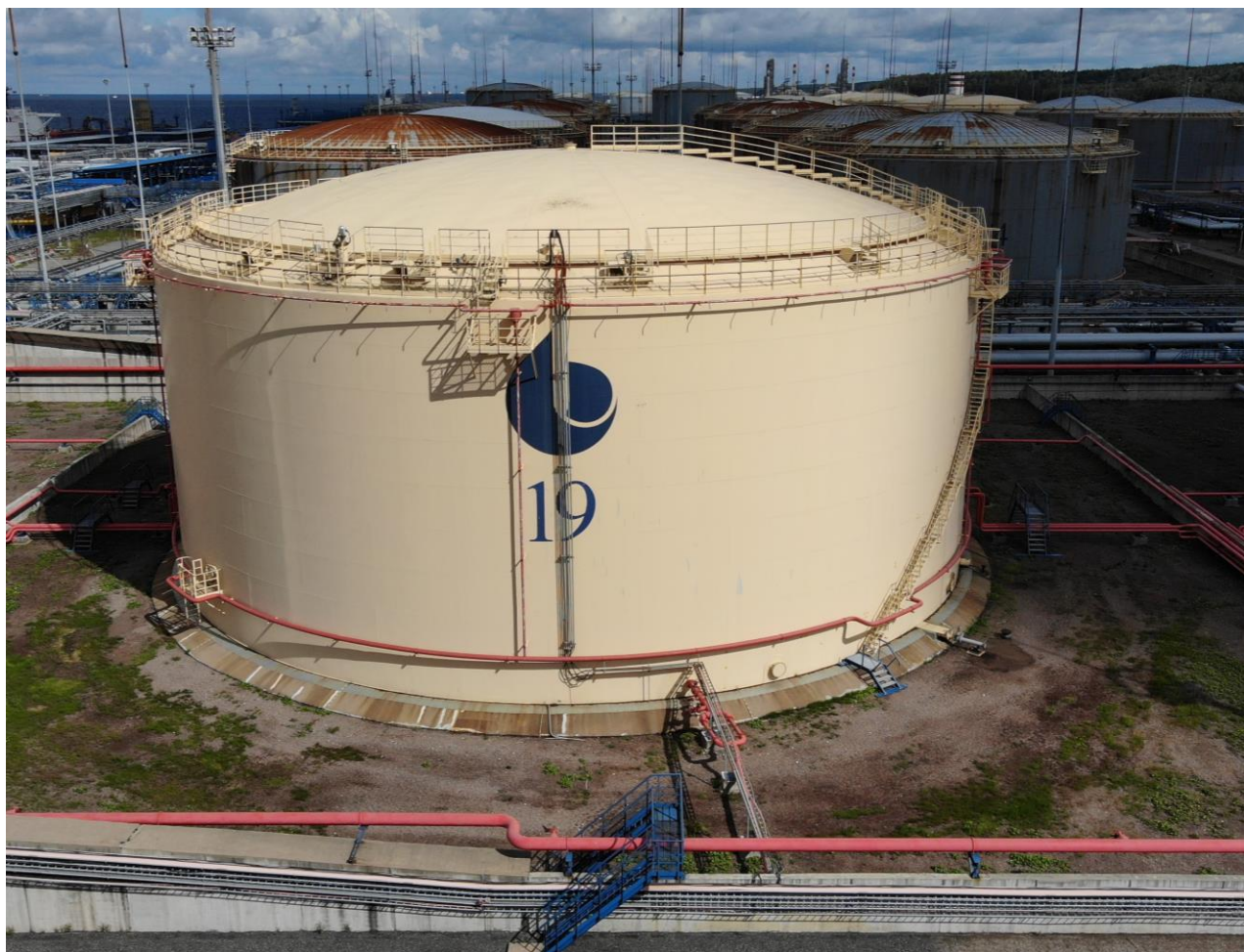
Рисунок 2 – Общий вид резервуара РВСП-30000
