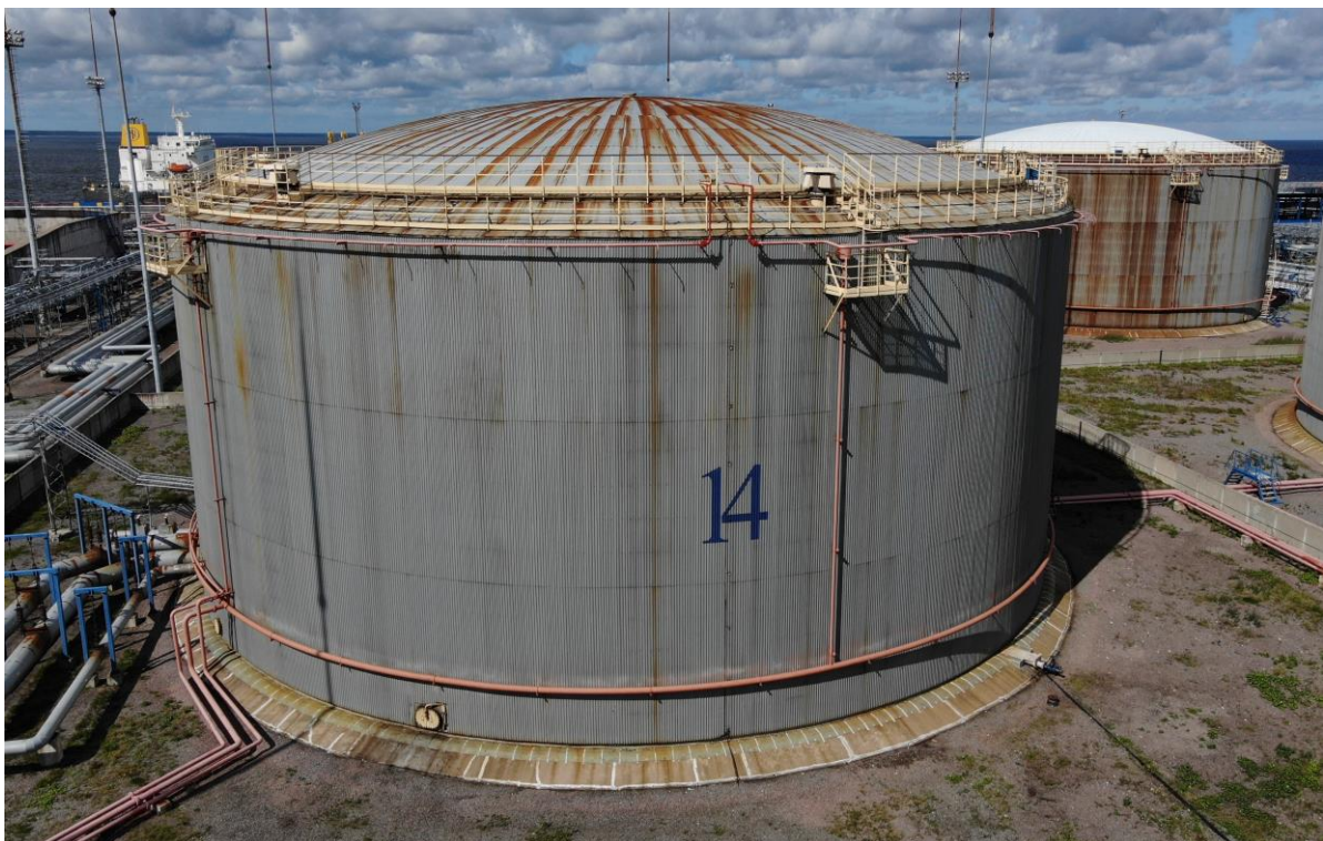
Рисунок 1 – Общий вид резервуара РВС-30000
