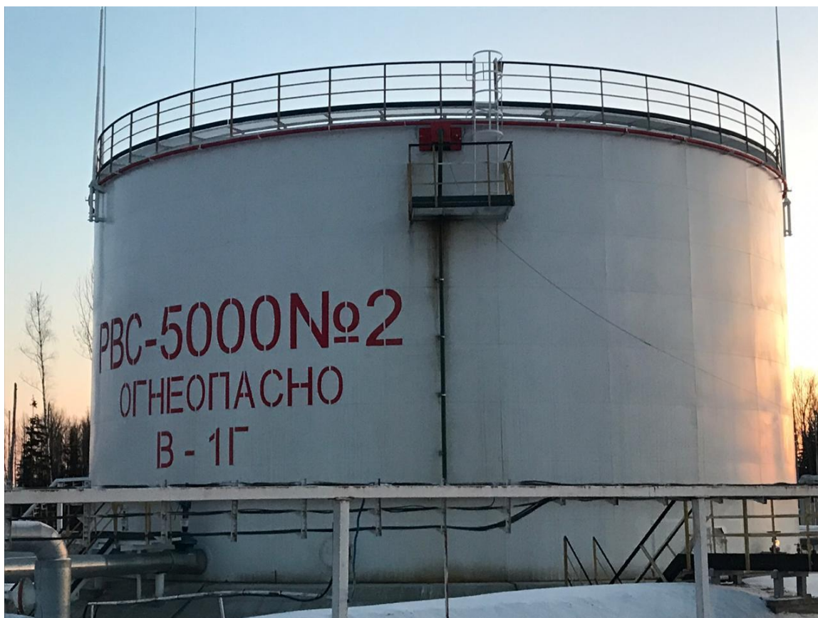
Рисунок 1 – Общий вид резервуаров стальных вертикальных цилиндрических РВС-5000
