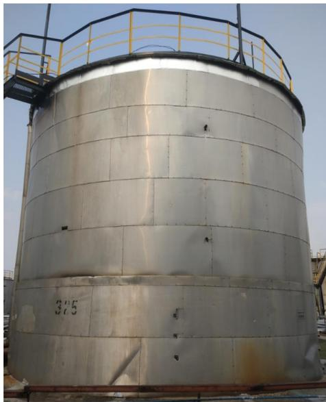
Рисунок 2 – Общий вид резервуаров стальных вертикальных цилиндрических РВС-400
