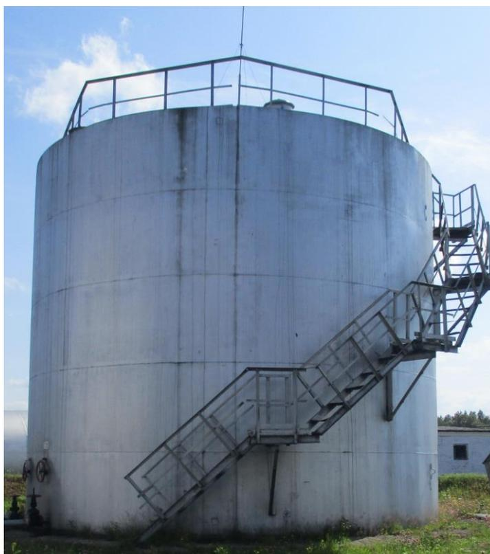
Рисунок 1 – Общий вид резервуара стального вертикального цилиндрического РВС-400
