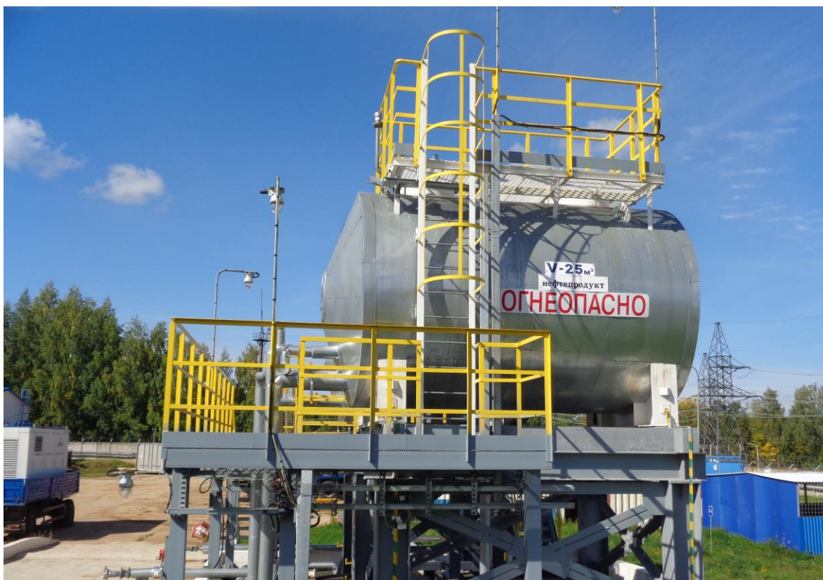
Рисунок 1 – Общий вид резервуара РГС-25
