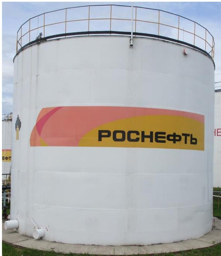
Рисунок 2 – Общий вид резервуара стального вертикального цилиндрического РВС-400, РВС-700
