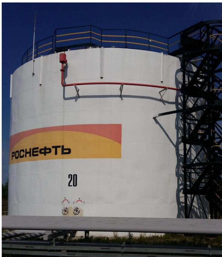
Рисунок 3 – Общий вид резервуара стального вертикального цилиндрического РВС-1000
