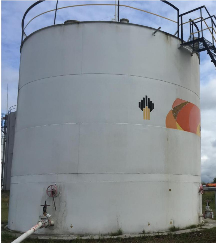
Рисунок 1 – Общий вид резервуара стального вертикального цилиндрического РВС-200
