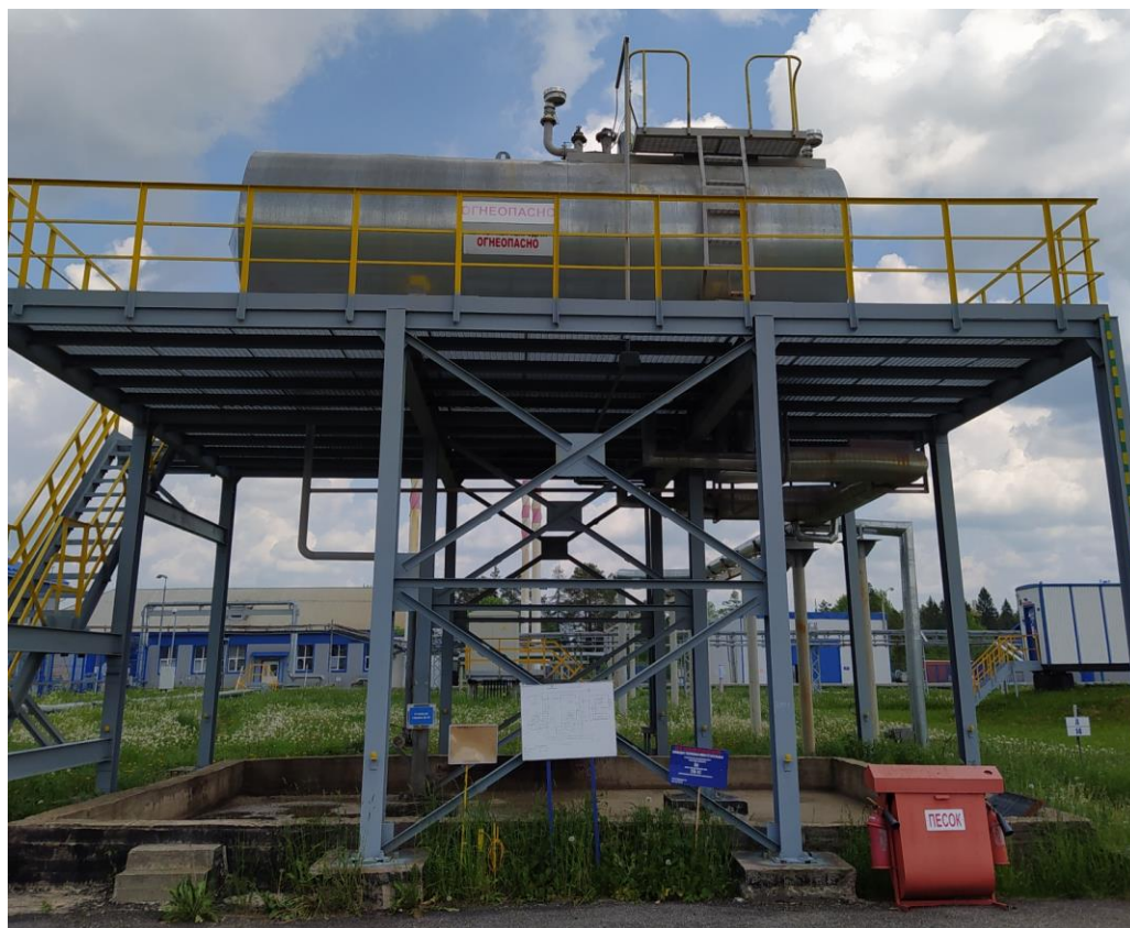
Рисунок 1 – Общий вид резервуаров РГС-20
