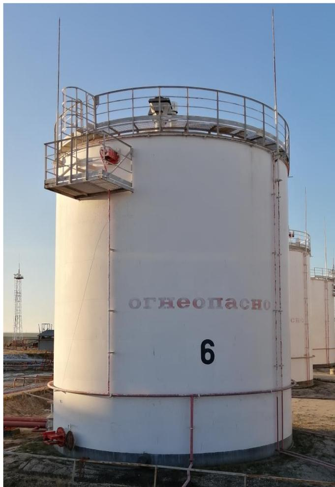
Рисунок 1 – Общий вид резервуаров стальных вертикальных цилиндрических РВС-1000
