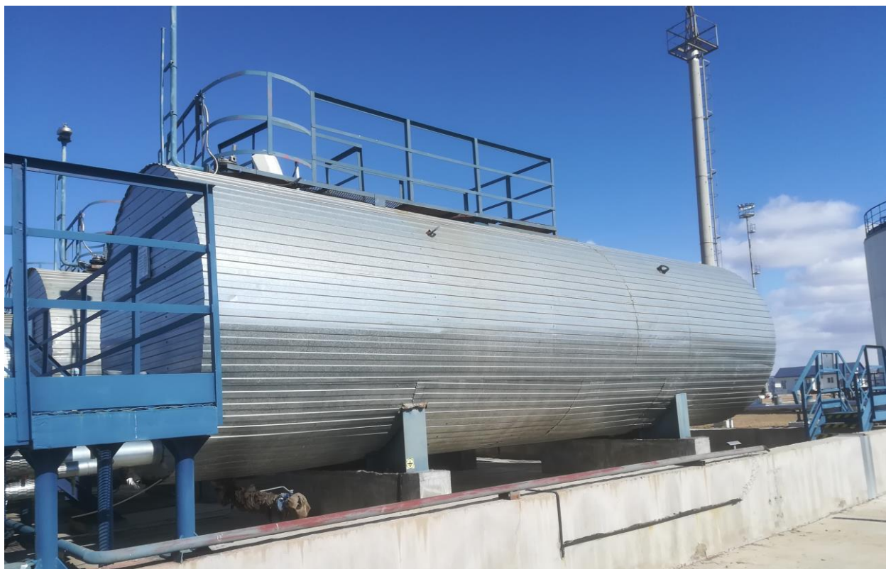
Рисунок 1 – Общий вид резервуаров РГС-50
