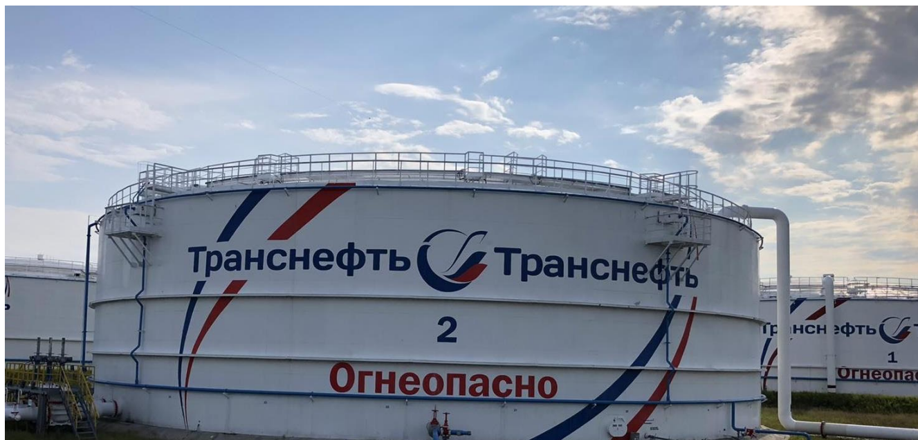
Рисунок 1 – Общий вид резервуара вертикального стального цилиндрического РВС-20000, заводской номер 2
