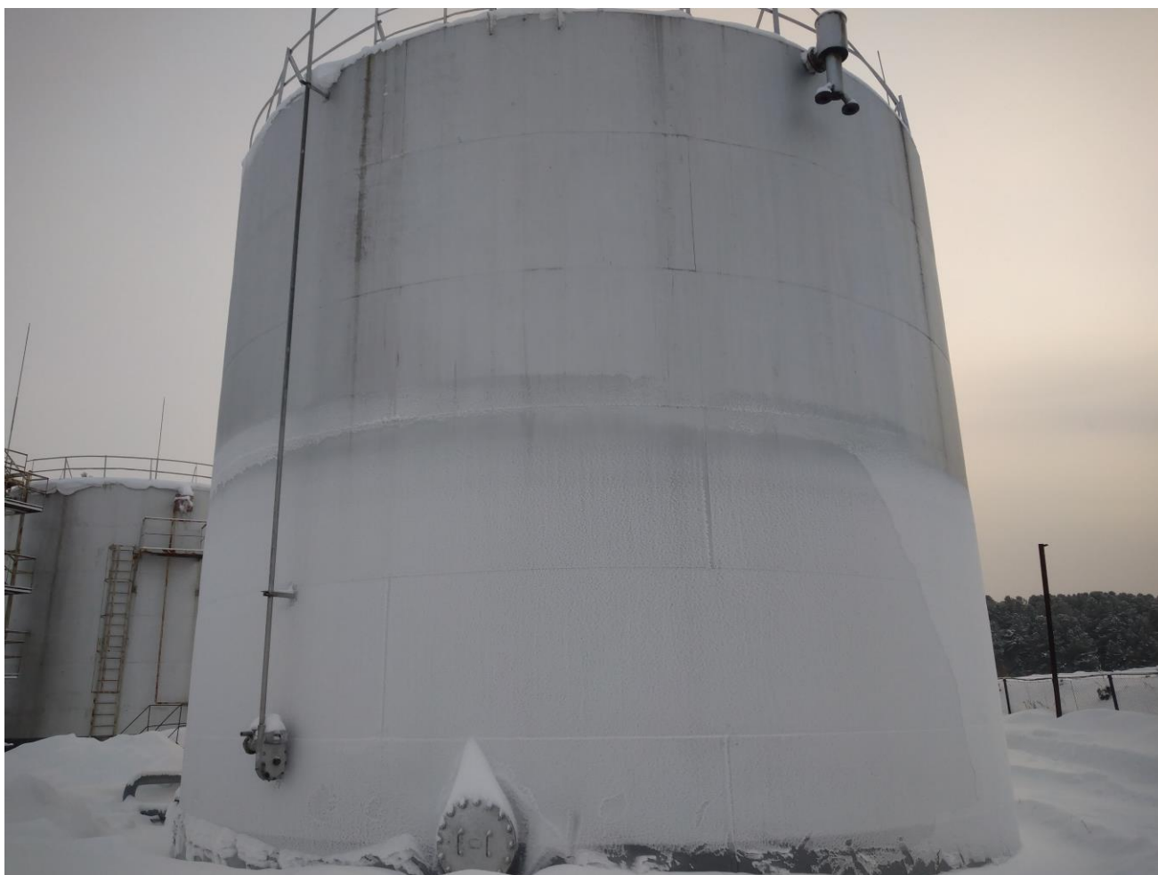
Рисунок 1 – Общий вид резервуара вертикального стального цилиндрического РВС-700, заводской номер 5
