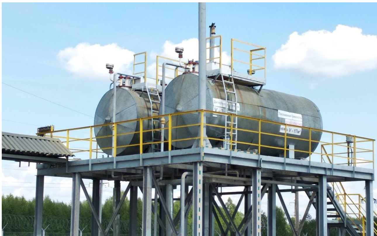
Рисунок 1 – Общий вид резервуаров РГС-20
