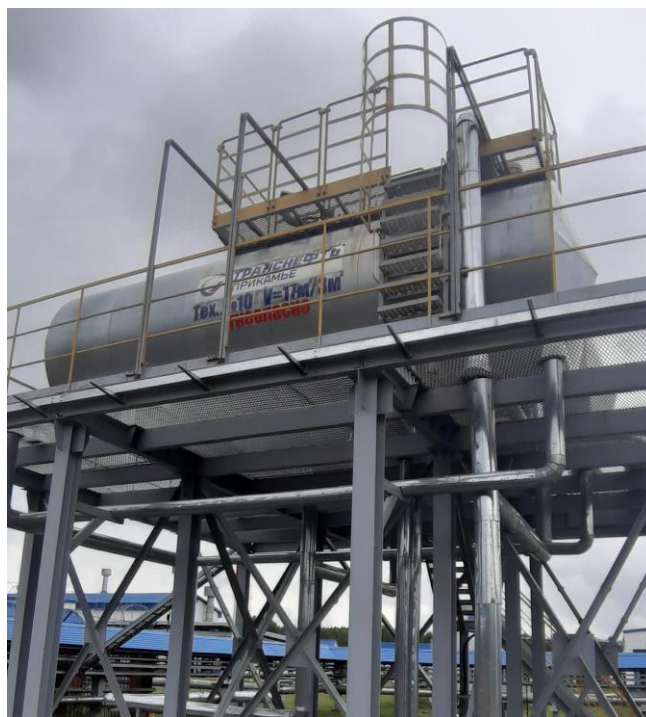
Рисунок 1 – Общий вид резервуаров РГС-20 №№268, 269
