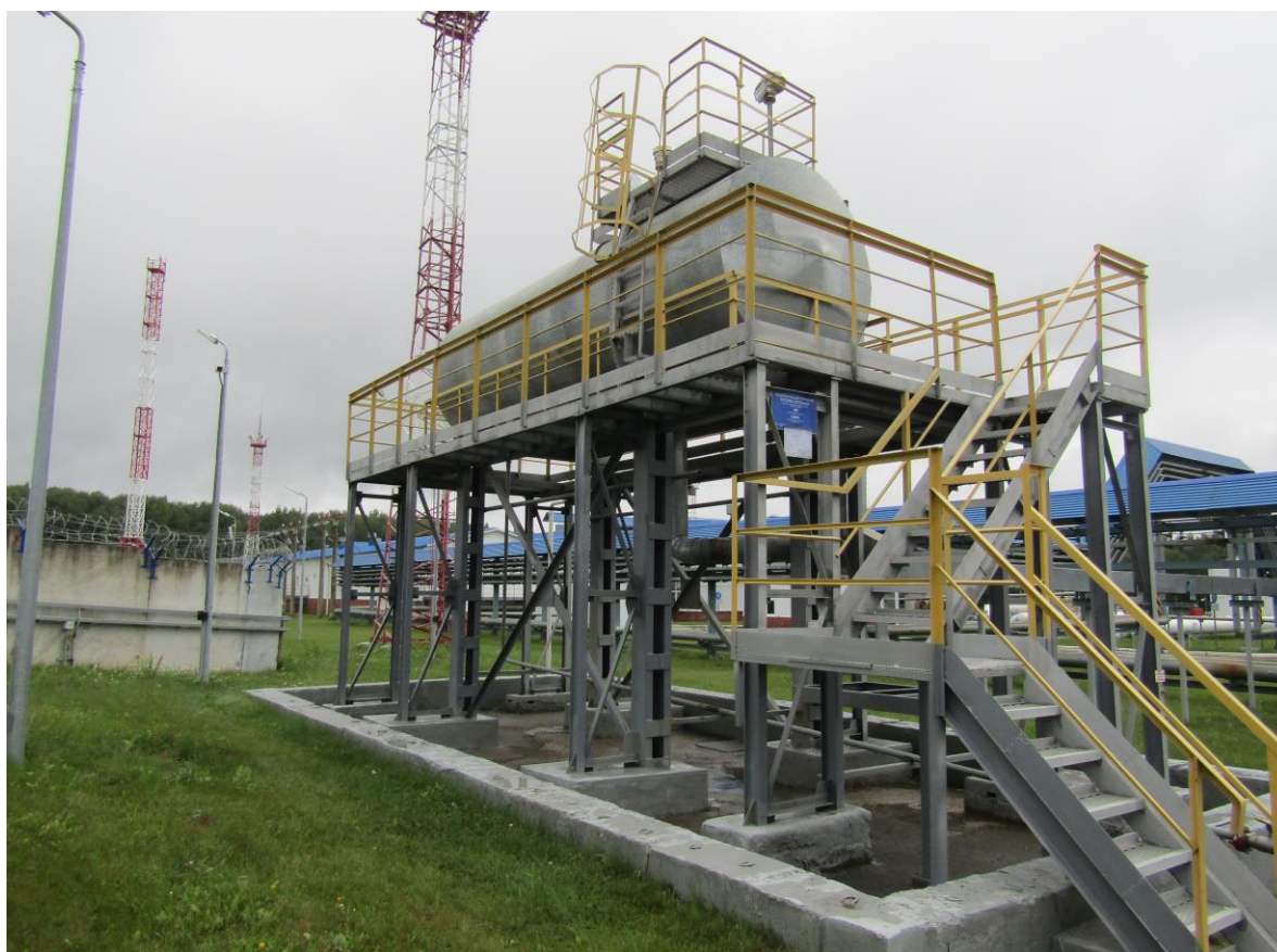
Рисунок 2 – Общий вид резервуара РГС-20 №98
