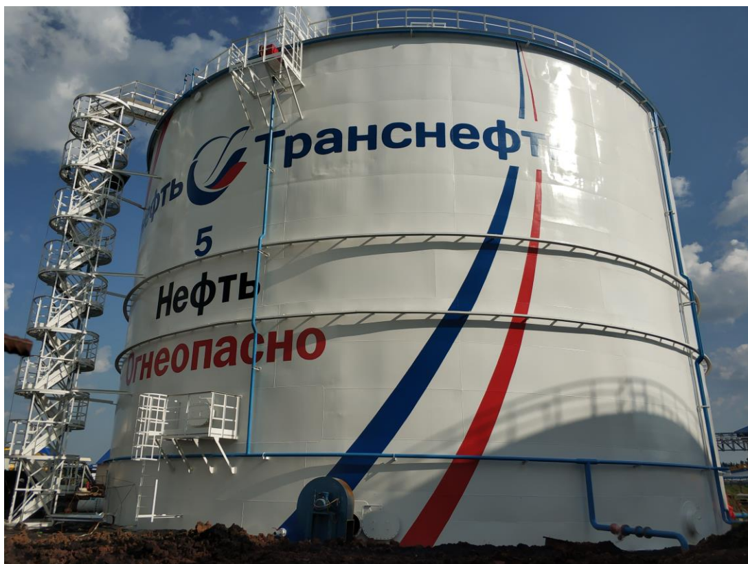
Рисунок 1 – Общий вид резервуара РВСП-10000
