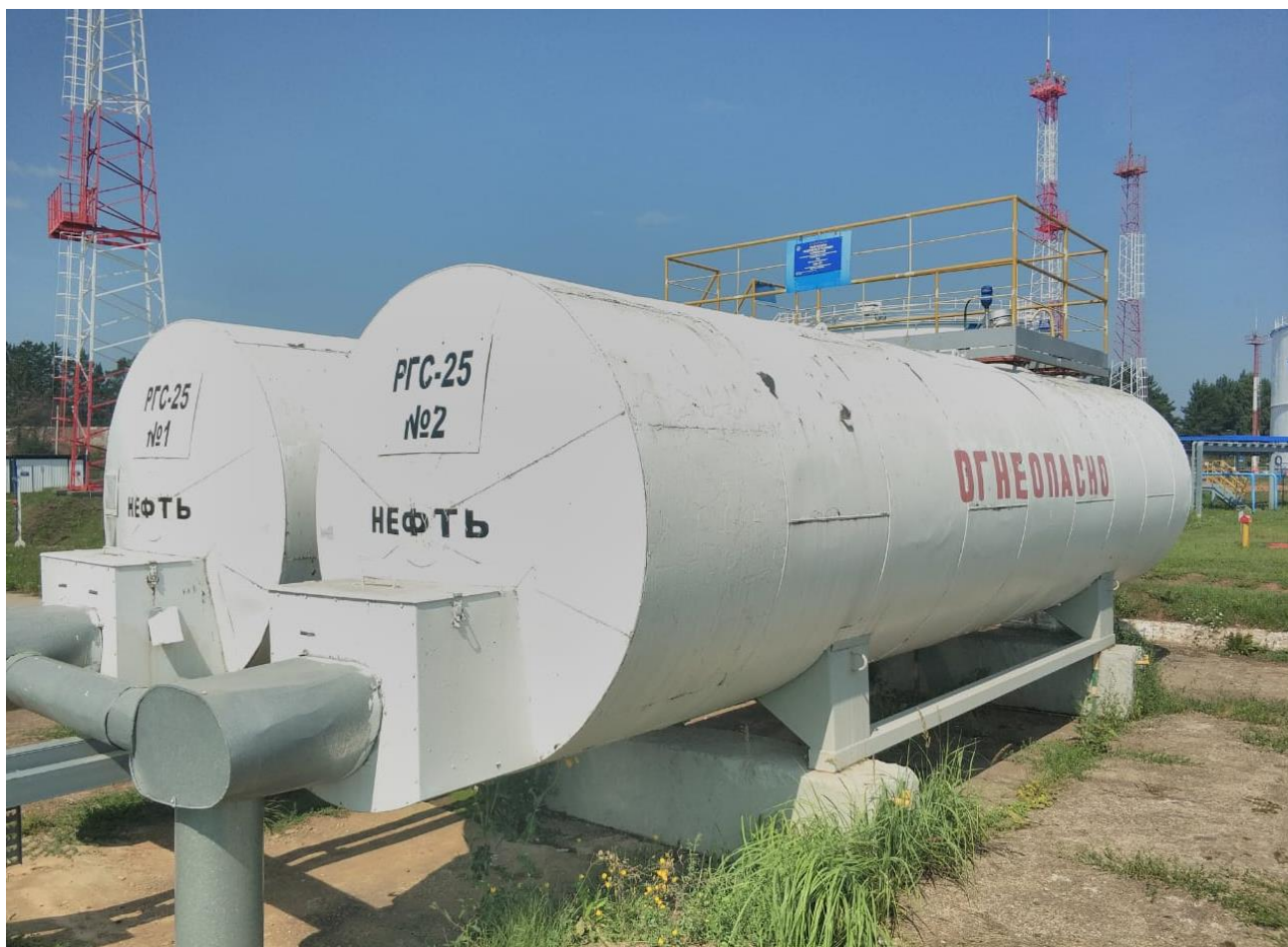
Рисунок 1 – Общий вид резервуаров РГС-25
