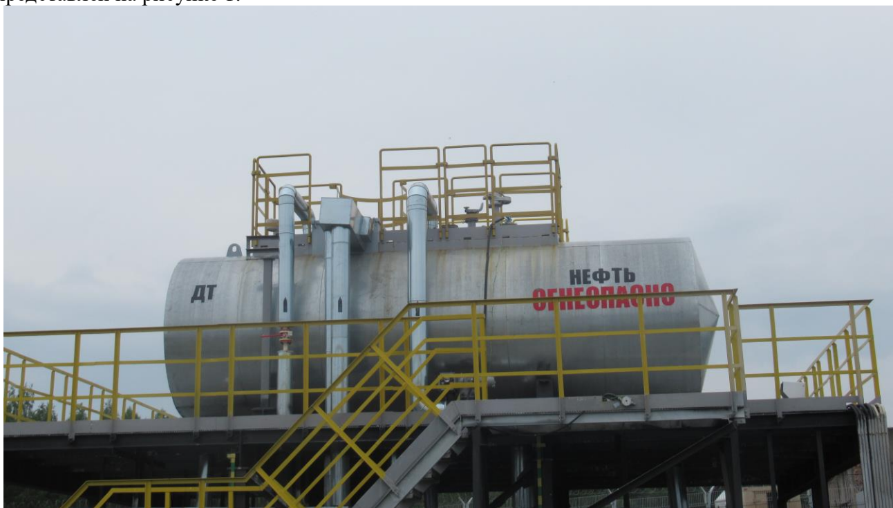
Рисунок 1 – Общий вид резервуаров РГС-20
